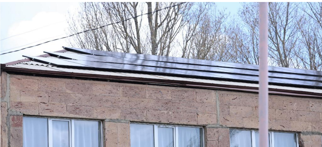
դասաժամՇողակաթ գյուղի դպրոցում գործող 20 կիլովատ ժամ հզորությամբ արևային ֆոտովոլտային կայան
